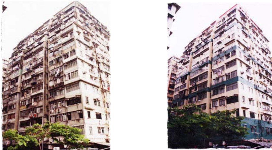
圖 7.1 中星樓復修前(左)和復修後(右)
